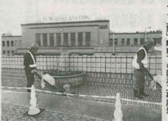
「上野」駅前で防汚工事風景
