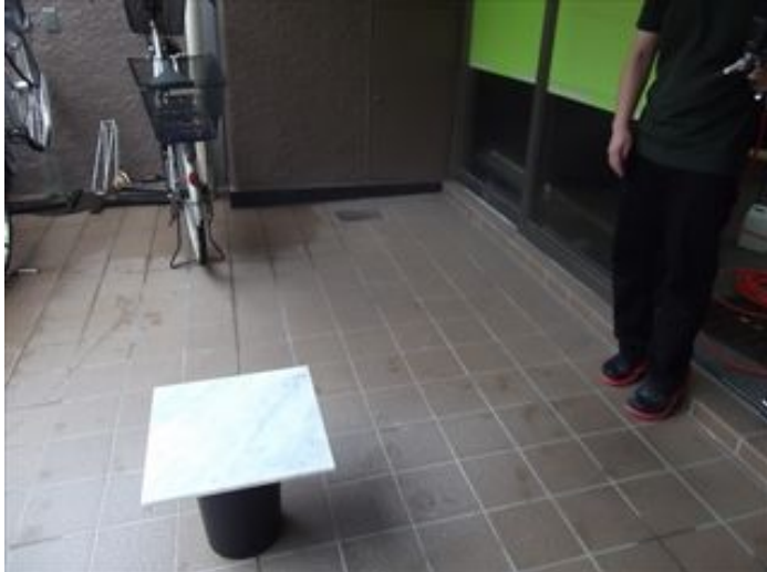
写真-6(⑦ 骨材の散布)
