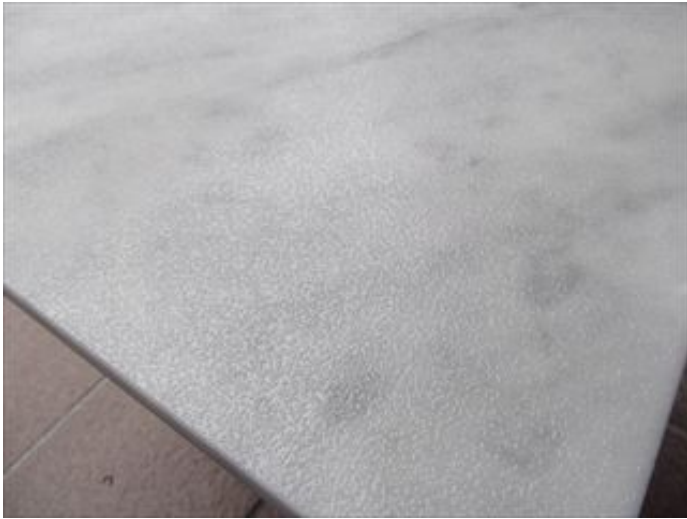
写真-7(⑦骨材の散布 拡大)
