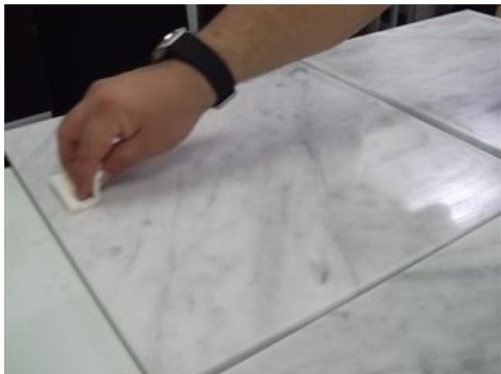
写真-3(④プライマー塗布)
